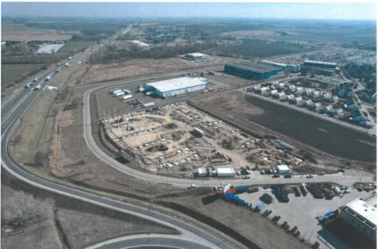
Výstavba logistické haly ve Vratislavi
